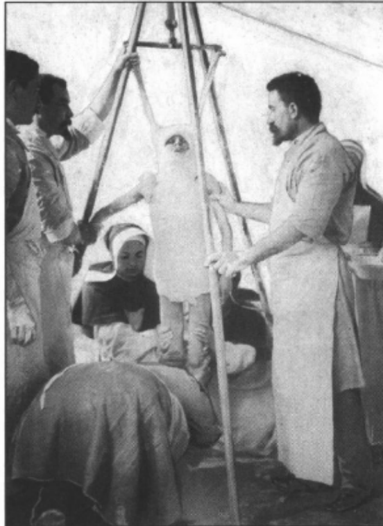
Confection du corset en suspension. Notez bien la traction axiale, qui mobilise 3 aides.
